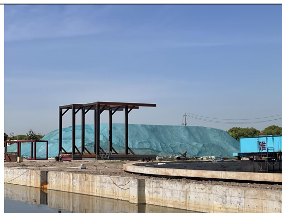
原料堆场覆盖防风抑尘网
